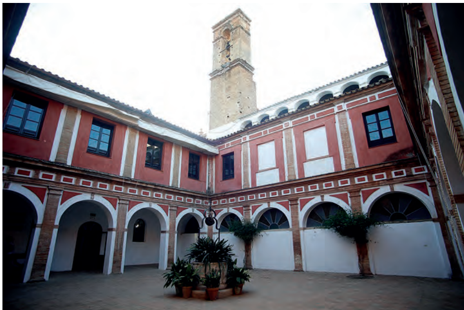
Figura 8 Claustro del convento de San Francisco (Palma del Río, Córdoba)
