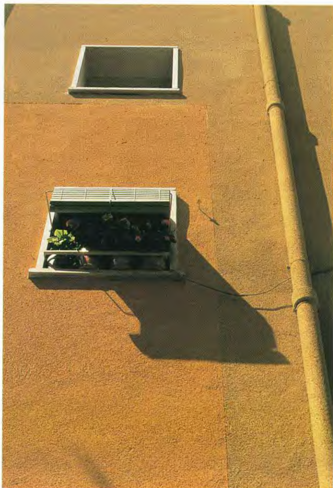
Detalle de rehabilitación. Barrio de Conde Duque. Madrid
